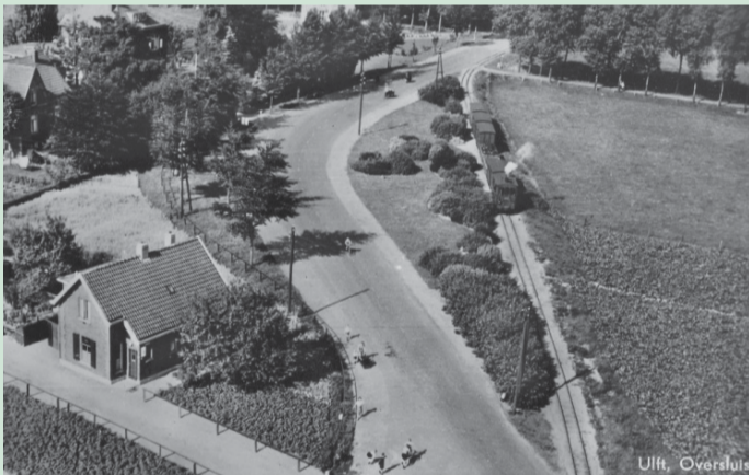
De tram door Bontebrug
